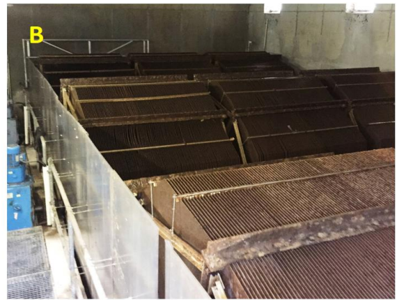
Abbildung 2-2: A) Blick auf die Scheibentauchkörperanlage mit vorgelagertem RÜB (V ca. 600 m³); B) Blick auf die drei in Reihe betriebenen Scheibentauchkörperwalzen
